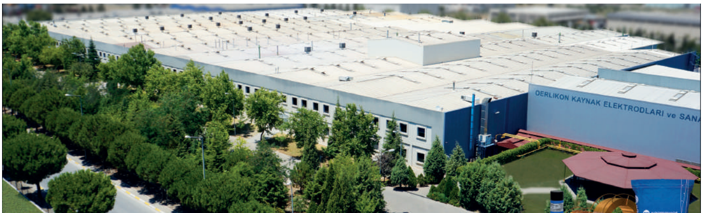
Fábrica de Consumíveis para Soldadura Organize Sanayi Bölgesi 2. Kısım, Manisa, Turquia
